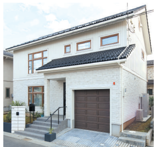
ビトイン・ガレージで電動木製オーバースライダーを採用。 細かいところにも快適性への配慮がみられる。
