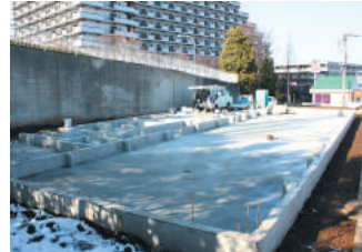
建設中の新社屋
