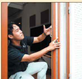
●木製サッシの点検確認中の高橋さん。
