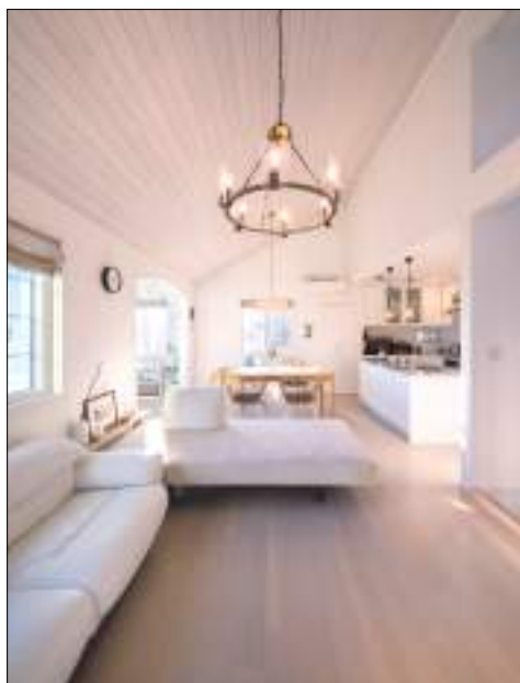
2階リビングからダイニング。勾配天井はパイン材の板貼り仕様。
