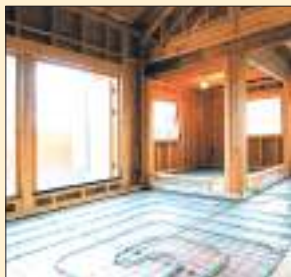
●構造材から内装・外装、設備まで膨大な材料を工事の進行に合わせて手配している柏木さん。
