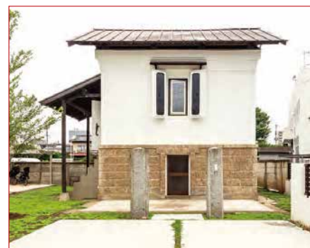
住まいづくりに合わせてリノベーションされた〈蔵〉は和モダンな雰囲気。 (施工:ジュテックホーム)
