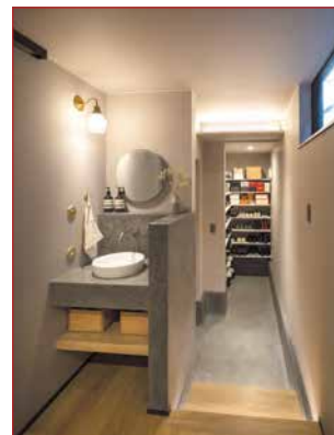
コロナ対策として、玄関脇にはモールドボックスを使った造作手洗いコーナーを設置。
