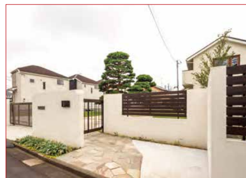
電動ゲートフェンスと木目調フェンス+ジョリバンド仕上げの門扉壁面。
