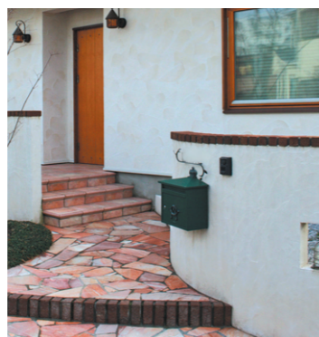
オープン外構のエントランス。ガラス骨材のユニブラルを使用し、コテ仕上によってやわらかい雰囲気。
