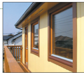
木製トリプルガラスサッシはLow-Eガラスを採用し、機能性だけでなくメンテナンス性にも優れた外観に美しいアクセントを添える。
