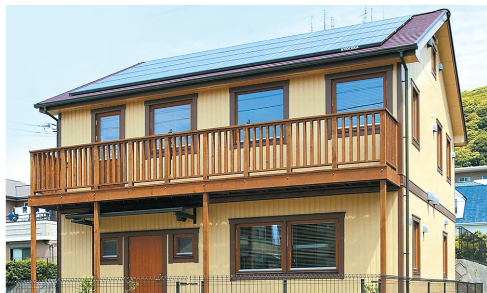
ソーラーパネルを設置したシンプルな屋根形状(遮熱構造)で夏の陽射しを遮断して快適な室内空間を実現。スウェーデン製トリプルガラスサッシには紫外線反射ガラス(Low-Eガラス)を採用。縦貼サイディングの外観に程よいアクセントを与えている。
