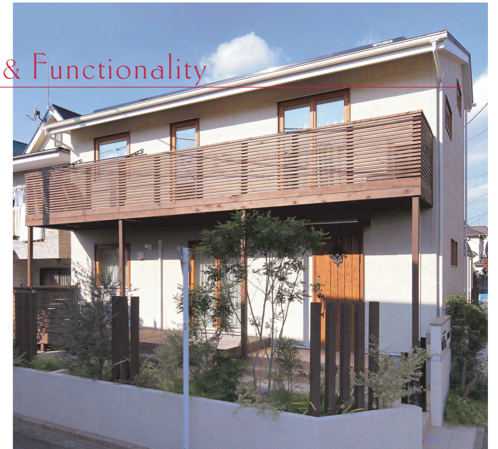
スウェーデン製木製3層ガラスサッシとウッドバルコニーをアクセントに、街並にしっかりと溶け込むアーバンな外観。屋根に太陽光発電システムを搭載。
