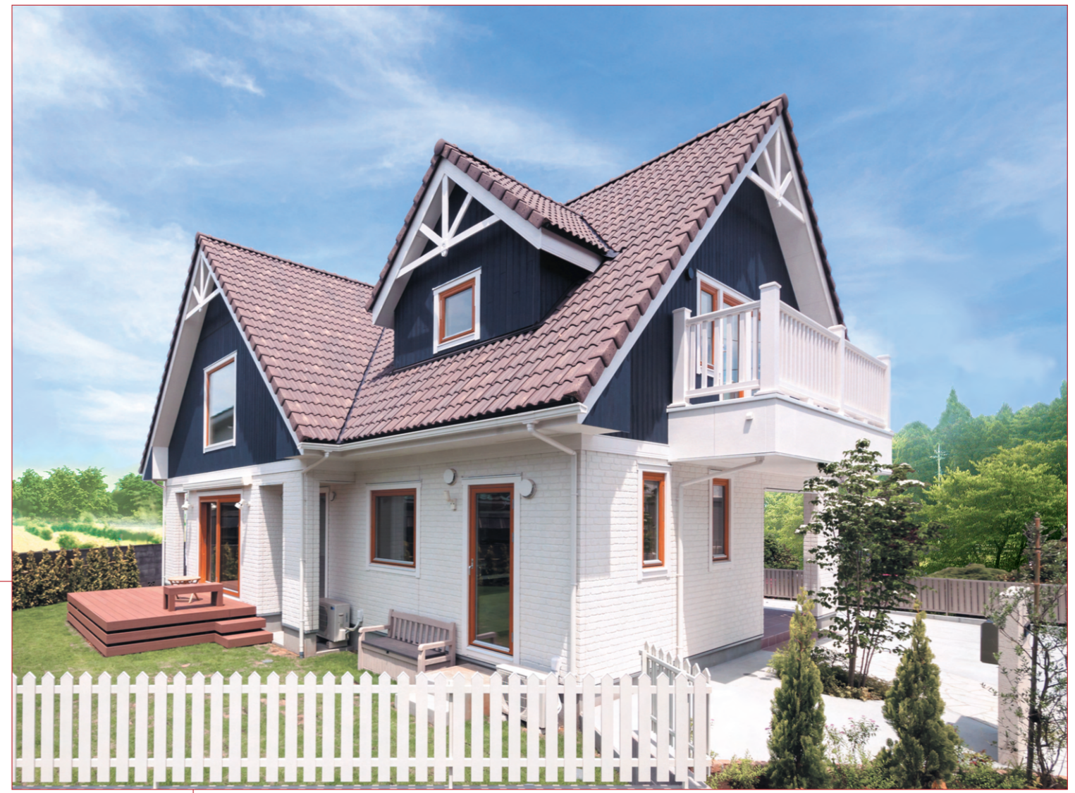
ゆったりとした大屋根が青空に映えるK邸。 外壁の白とブルシアンプル、屋根のショコラブラウン、 芝生のグリーンが美しく調和している。
