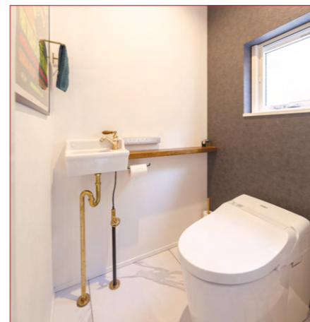
トイレの水栓・パイプも引くデザインに。
