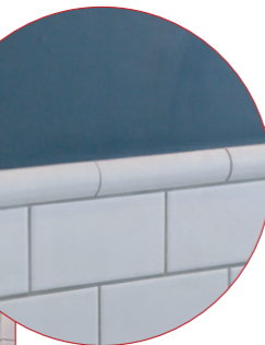
ブルーの壁と馬貼りのSUBWAYタイルの間には見切りのRタイルを採用。
