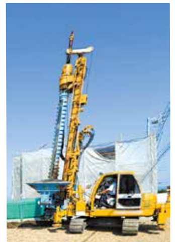
地盤改良工事
