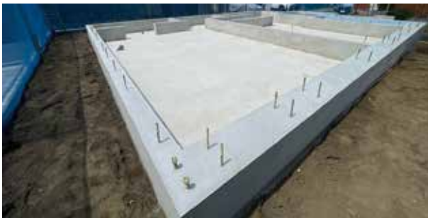
コンクリートは、1cmあたり約240kgの荷重に耐える圧縮強度24N/mm 2 を採用しています。
