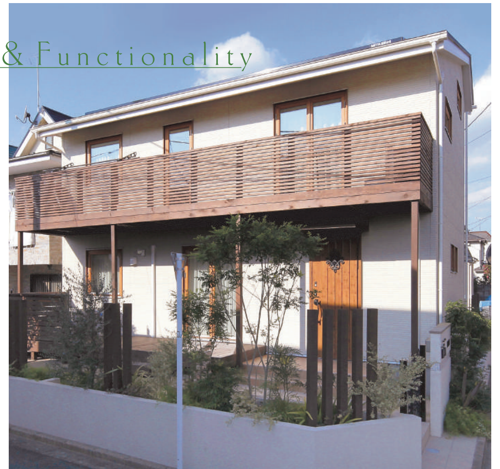
スウェーデン製木製3層ガラスサッシとウッドバルコニーをアクセントにしたアーバンな外観が街並みこっそり溶け込む。屋根には太陽光発電システムを搭載。
