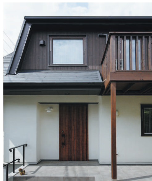
1階・2階の外壁はツートーンカラーによって、シックでメリハリのある外観に。開放感溢れるエントランス。
