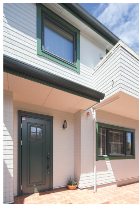
高気密・高断熱のスウェーデン製木製3層ガラスサッシと玄関ドア。
