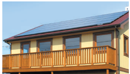
4.3kwのソーラーパネルは省エネだけでなく非常時の発電も可能。
