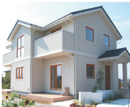
光触媒の外壁材は汚れにくく、劣化しにくいので、歳月が経過しても変わることなく美しい外観を保つ。
