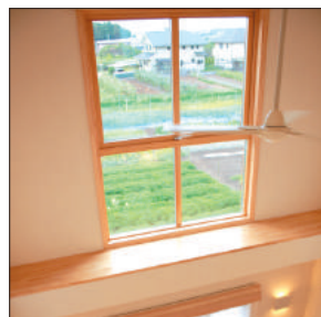
スウェーデン製の木製トリプルガラスサッシ。180度回転する窓は掃除も簡単。メンテナンス性に優れている。
