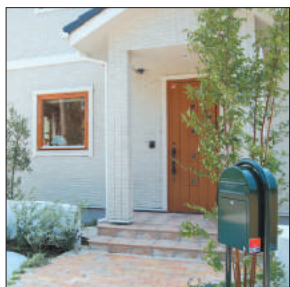
スウェーデン製の木製トリプルガラスサッシ。180度回転する窓は掃除も簡単。メンテナンス性に優れている。
